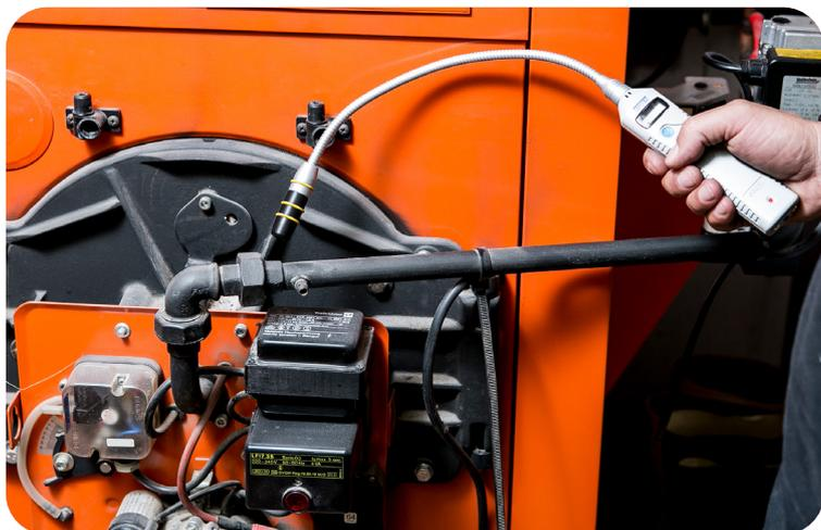
Il cercafughe ecom-LSG è progettato per rilevare in modo rapido e affidabile le perdite negli impianti a gas. A differenza degli spray cercafughe, che possono gonfiare le guarnizioni, ad esempio in canapa, e quindi sigillarle di nuovo temporaneamente, il rilevamento delle perdite con l'ecom-LSG è semplice e senza problemi.
